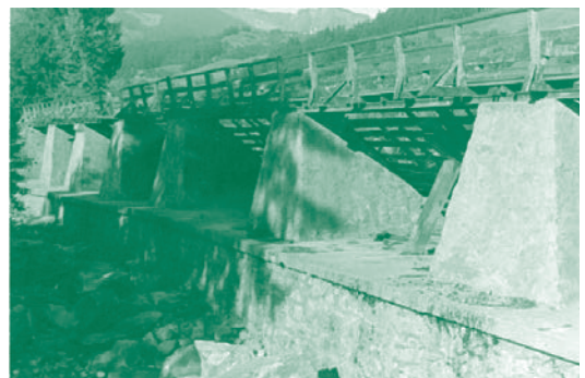
Am Hauptrechen beim Muntliger Steg endet die eigentliche Triftanlage. Um das angeschwemmte Holz sicher festzuhalten, war der Rechen an schweren, gemauerten Sockeln befestigt.
