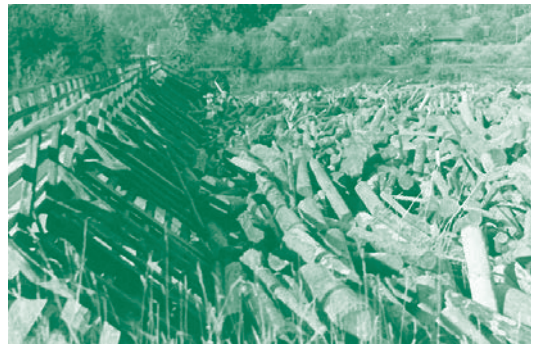
Der große „Ländeplatz“ konnte über 3000 Raummeter-Holz fassen. Durch den Druck des Wassers wurde hier das Holz mitunter mehrere Meter hoch aufeinander geschoben. Die „Ausländung“, also der Abtransport des Holzes auf den Holzplatz, erfolgte erst bei Niederwasser.
