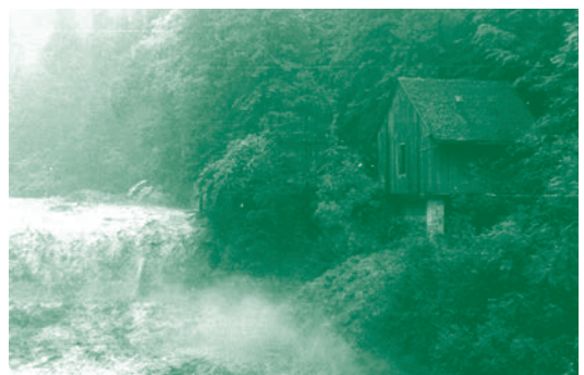
Bei Hochwasser wurde der schwer verankerte Rechen oft meterhoch überflutet. Dadurch ging viel Holz, vorwiegend unbezeichnetes Wildholz, verloren.
