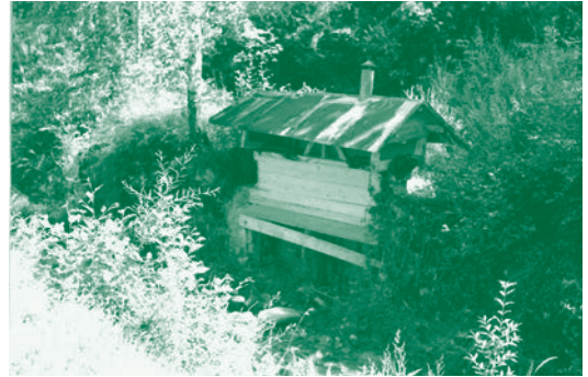
Mit Hilfe der „Sandläden“ konnte Kies und Sand gewonnen werden, das durch hölzerne Lattenroste im Boden des Kanals in die seitlichen Sammelbecken abgeführt wurde.
